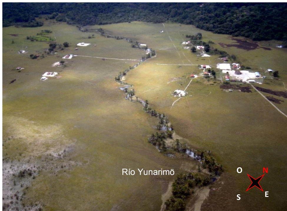
Figura 8. Vista aérea de San José de Unötöi. Fuente: Archivo, FB. 2012
