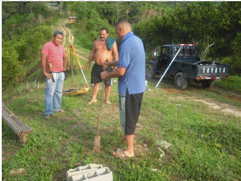
Figura N°38: Construcción del Vértices 3
