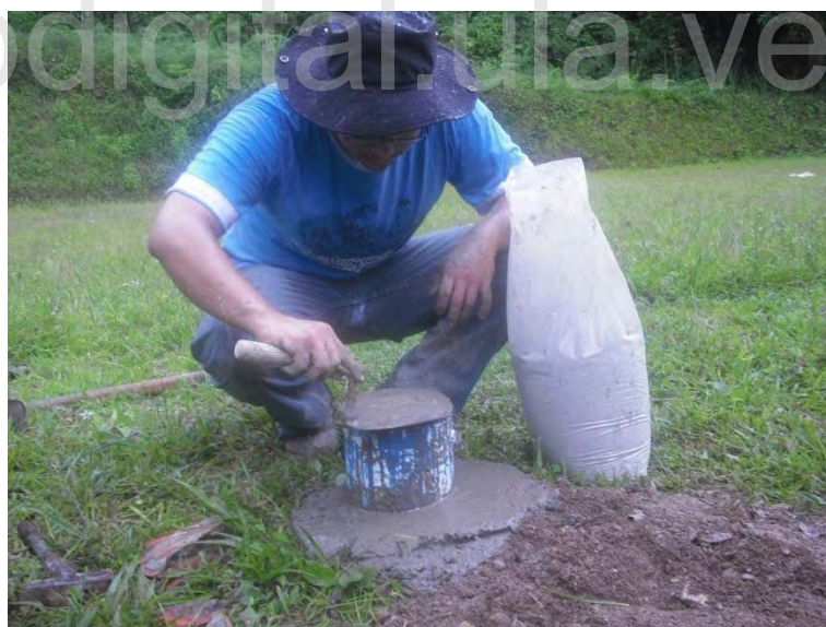
Figura N°34: Acabado del Monumento del Vértice 1
