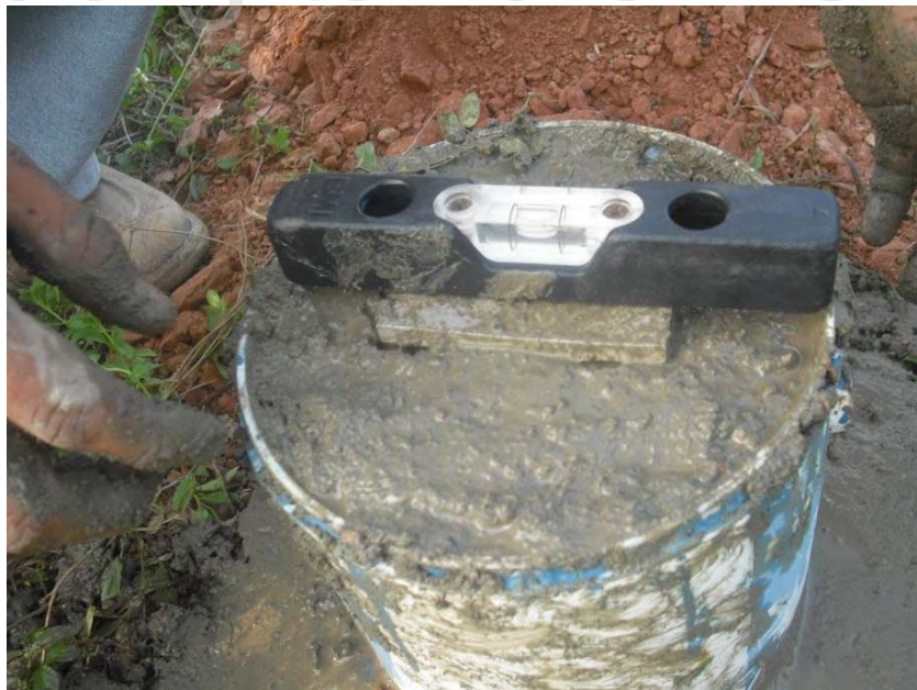
Figura N°37: Nivelación de los Vértices 2 y 3
