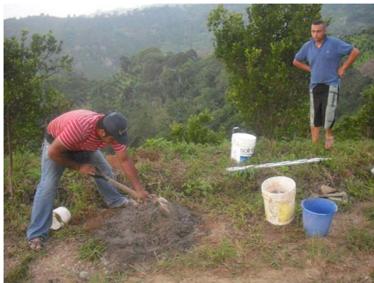
Figura N°28: Construcción Monumento Vértice 4
