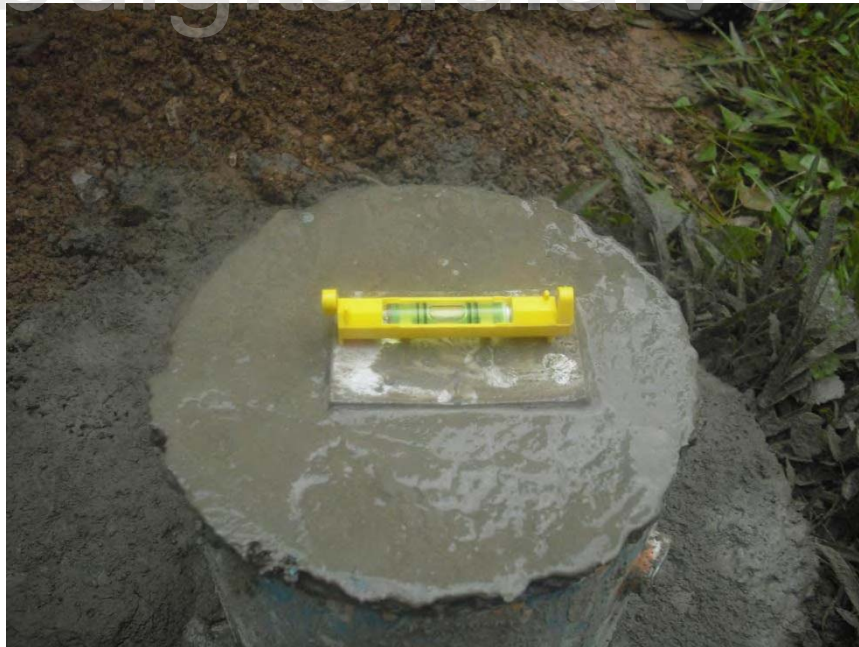
Figura N°35: Excavación y Nivelación del Monumento del Vértice 1
