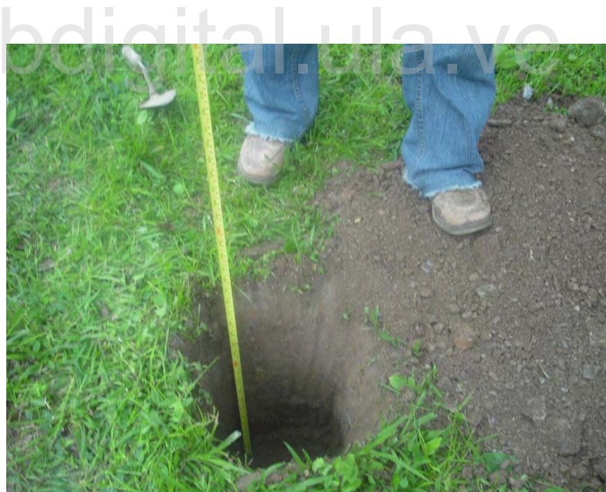
Figura N°33: Excavación para el Monumento del Vértice 1
