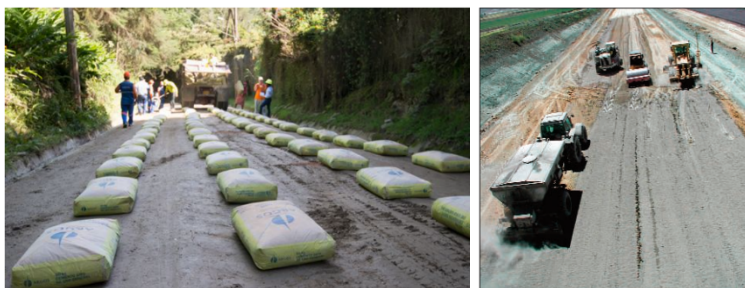
Figura 7 Estabilización con cemento
