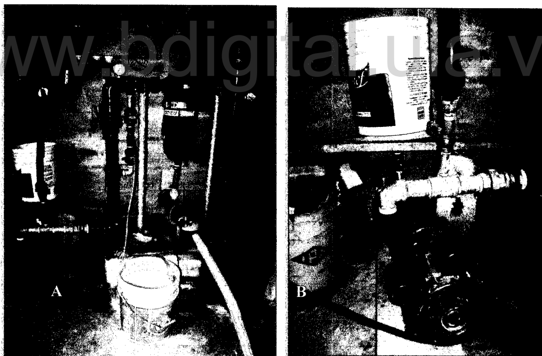
Figura 3.7. Equipo del cabezal de riego. A: Cabezal de Riego y sus accesorios. B: Sistema utilizado para la inyección del fertilizante.
