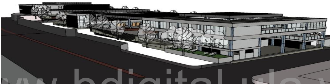
Figura 4.1 Vista del conjunto de sur a norte
