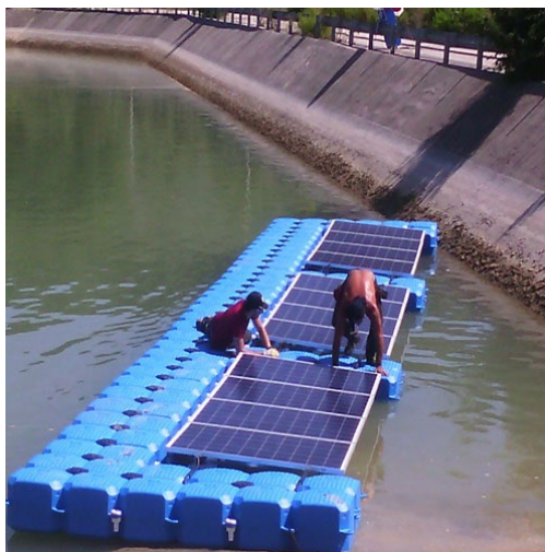
Figura 2.13. Estructura de pontones para paneles solares [33].
