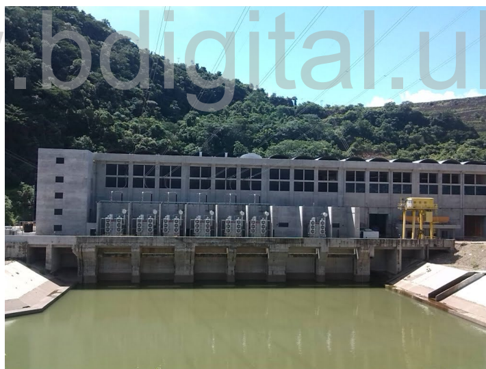
Figura 3.5. Imagen externa de la Central Fabricio Ojeda [64].
