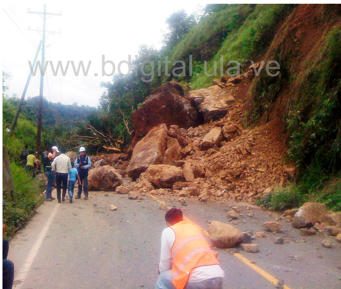
Fotografía N° 2 La vía a la Aldea la Blanca está cerrada por derrumbe
