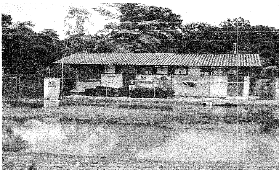
Fotografía N° 11: Aguas estancadas dejadas por las crecidas.
