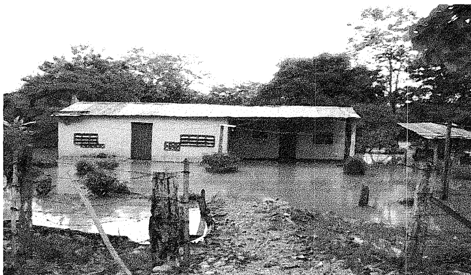
Fotografía N° 14. Vivienda inundada durante varios días.
