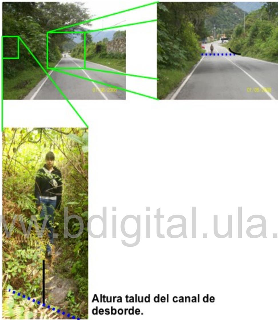
Figura 3.18: Cercanías del punto de desborde de la quebrada La Pedregosa. La figura muestra al fondo un lomo encargado de desviar la quebrada La Resbalosa.
