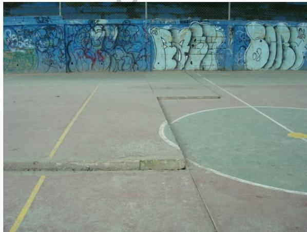
Fotografía 05. Detalle del desplazamiento de las losas que conforman la cancha deportiva, en el Sector 1 de Musabás.
