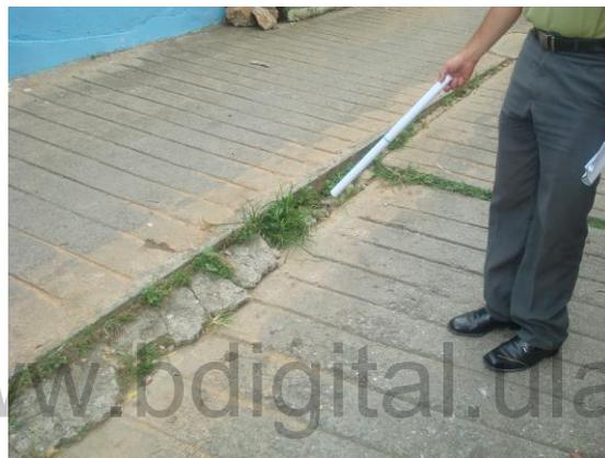
Fotografía 12. Desplazamiento de las losas que conforman las caminerías de este sector.
