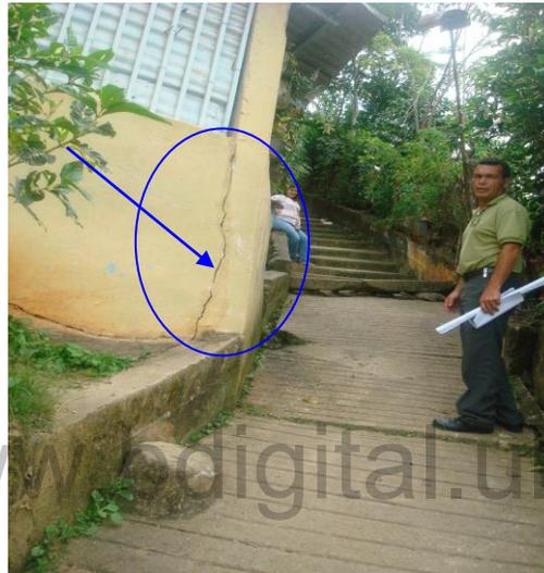
Fotografía 10. Fracturas en paredes externas de las viviendas ubicadas en el área objeto de estudio. Nótase la inclinación de la vivienda y caminería a favor de la pendiente.
