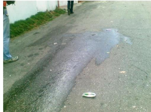
Fotografías 06 y 07. Exfiltraciones en la vía principal del sector Musabás, posiblemente por fugas en las redes de agua para consumo.
