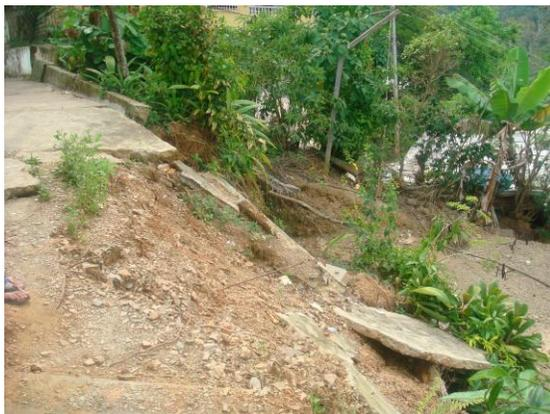
Fotografía 11. Movimiento en masa de tipo traslacional que afectó una de las caminerías del sector.
