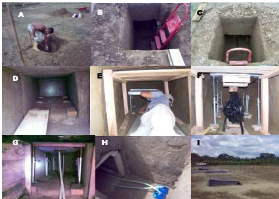
Figura II-19. Secuencia de instalación de los lisímetros. A. Construcción de calicata inicial, B y C. vista de calicata y entrada del túnel, D. Túnel y soporte de patas del lisímetro, E. Colocación de lisímetro, F. Vista del gato para subir y ajustar el lisímetro, G. Lisímetros instalados y conectados, H. Envases colectores, I. Vista general y techo sobre la calicata, en E y G se observa el revestimiento de madera del techo y paredes del túnel.
