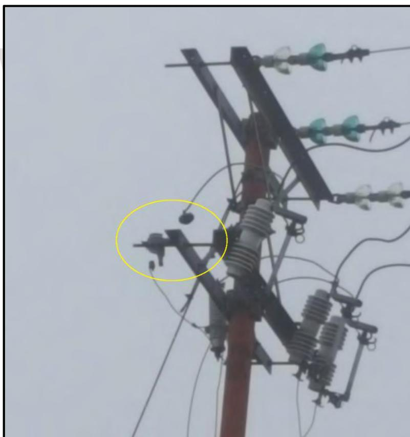
**Figura 3.15** - Imagen del estado en el que se encuentra el dispositivo de protección (Pararrayos).
