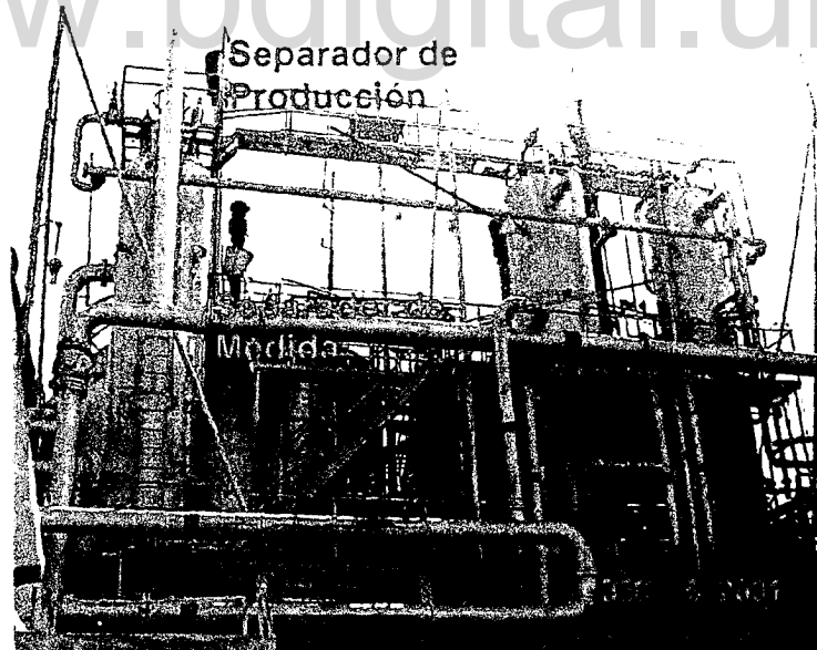
Foto N° 2.4 Separador de Producción y Medida EF-2-6
