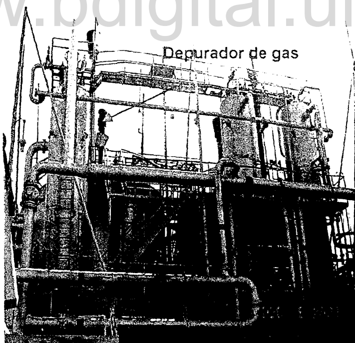
Foto N° 2.5. Depurador de Gas EF-2-6
