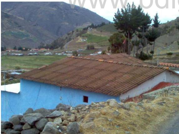
Foto 31. Techo de asbesto.
