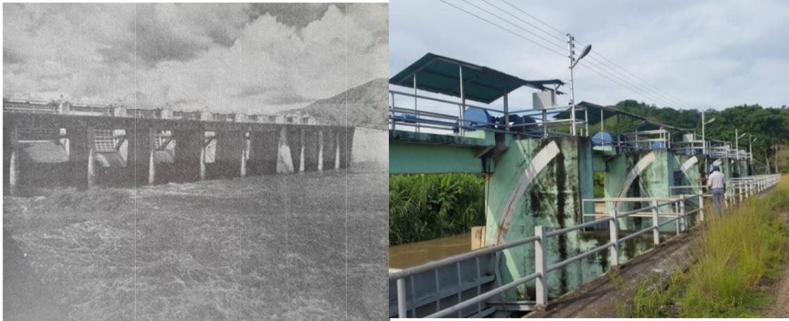
Figura 0.3. Compuertas de regulación de niveles y alivio en el río Cojedes. Fuente: Izquierda: (1964); Derecha: elaboración propia (2017)
