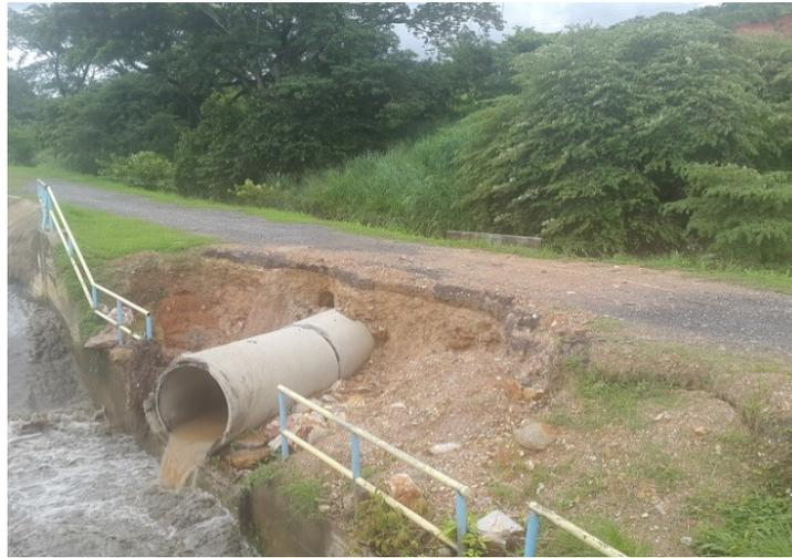
Figura 0.9. Tubería de rebose del drenaje de Cerro el Loro hacia el canal de derivación Sarare. Fuente: elaboración propia
