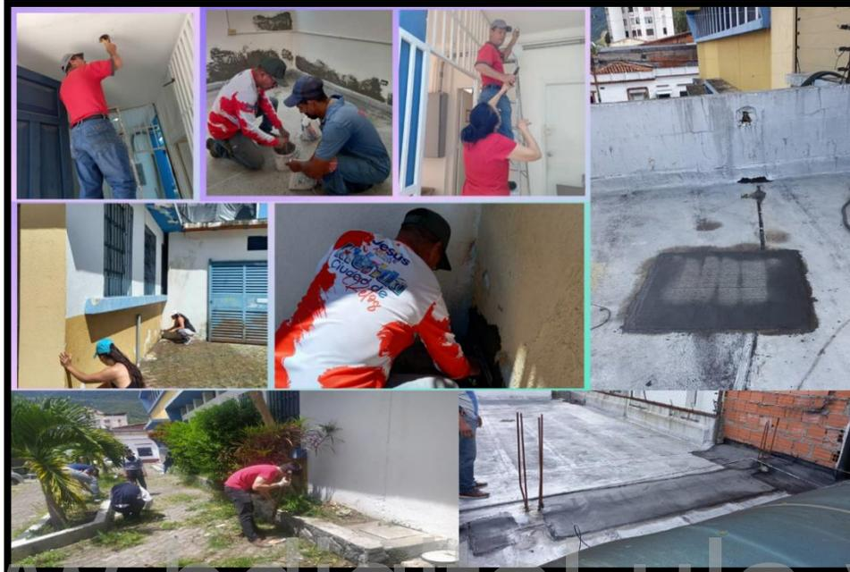
**Imagen 12: Colocación del manto asfáltico para la reparación de las filtraciones, limpieza de áreas verdes y reconstrucción del interior del consultorio**
