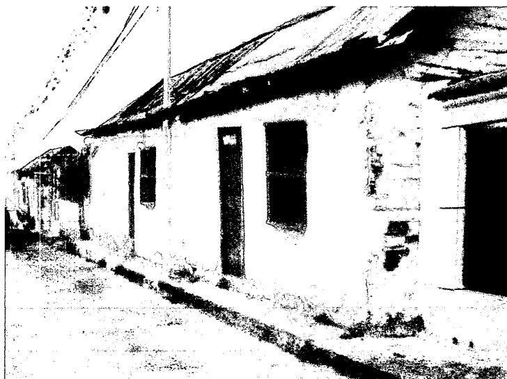
Figura 35. Fachadas de las viviendas.
