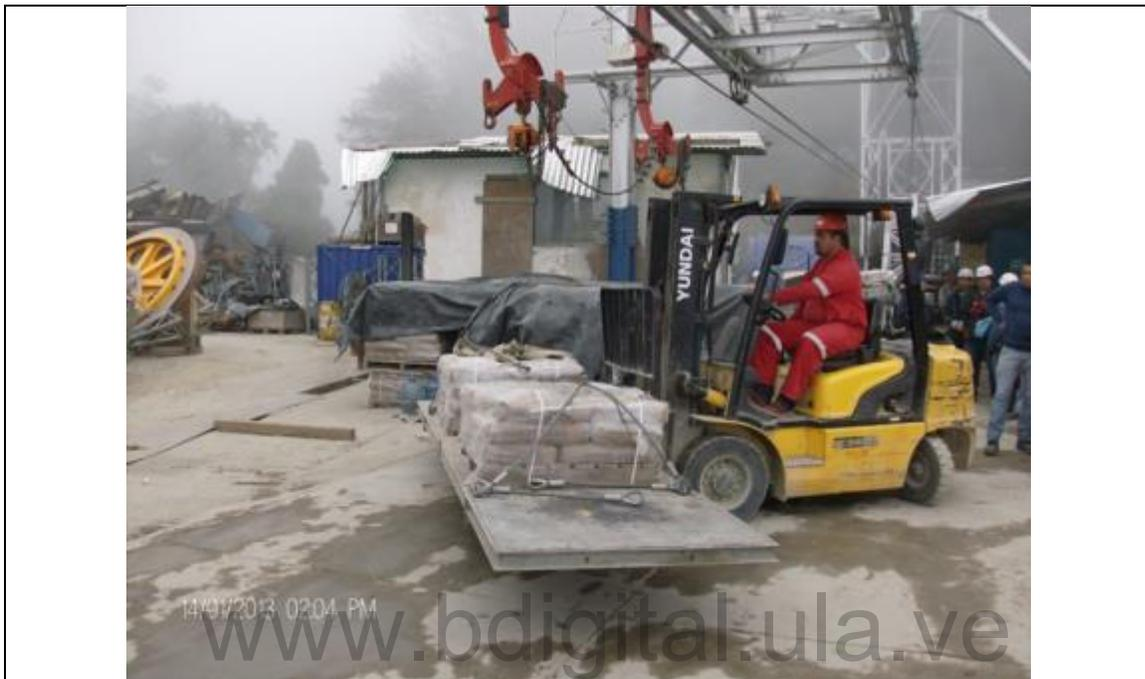
**Figura 19. Transporte de material por teleférico de carga**
