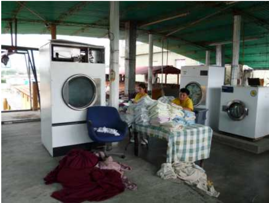
ÁREA DE LAVANDERÍA SIN SEÑALETICA E INADECUADA PARA ESA LABOR PERSONAL SIN RESPECTIVOS UNIFORMES PARA EVITAR RIESGOS
