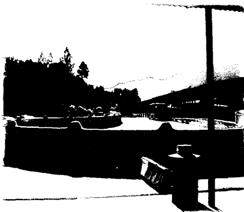
Foto N° 4 Estación La Calera
