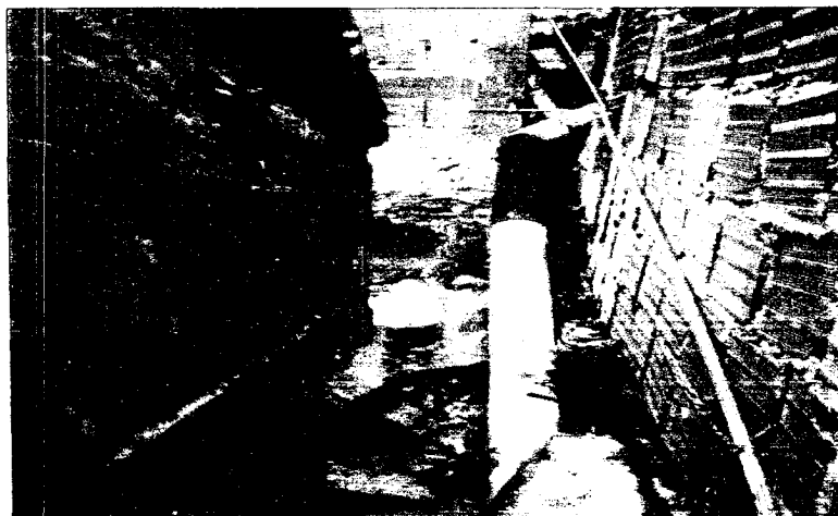
Foto n° 10 Tuberías de aguas servidas superficiales y deterioradas
