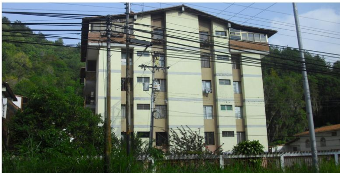
Fotografía 5 Uso vivienda multifamiliar
