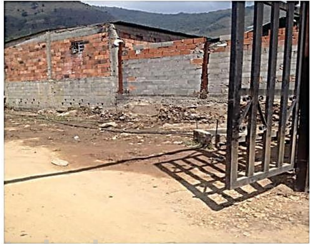
b) Conexión del sistema de red agua potable sin facturación
