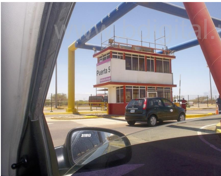
Entrada Principal Refinería de Amuay
