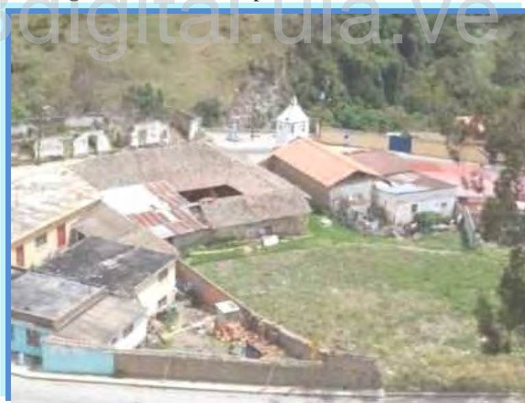
Fotografía No.27. Vista parcial del caserío La Cruz
