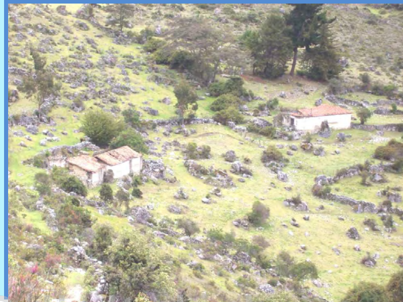
Fotografía No. 46. Viviendas de habitabilidad ocasional en Las Margaritas.
