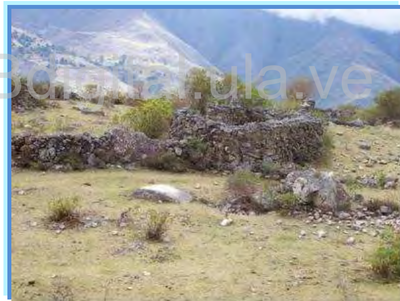
Fotografía No. 24. Ruina de vivienda en El Capadero.
