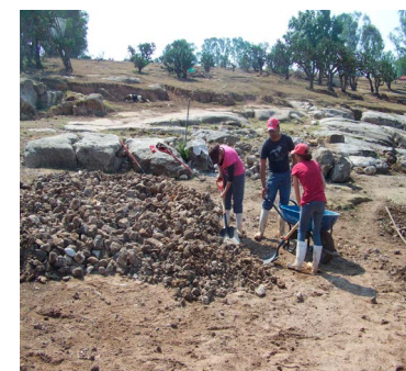
Fotografía 2. Limpieza de la presa: rocas.
