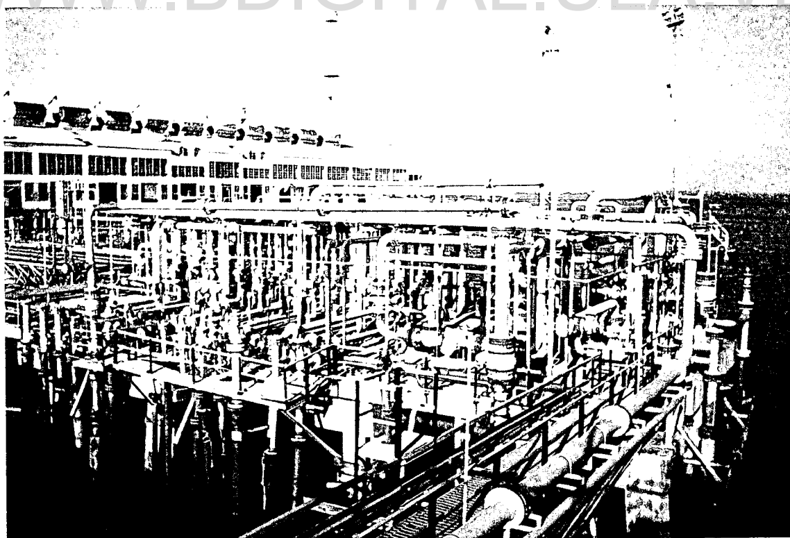
Fotografía B.1. 27.- Isla de Distribución. Vista general
