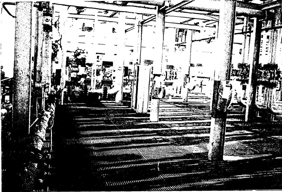
Fotografía B.1. 30.- Isla de Distribución. Al fondo sistema de transferencia de gas. A la izquierda múltiple de gas de levantamiento artificial
