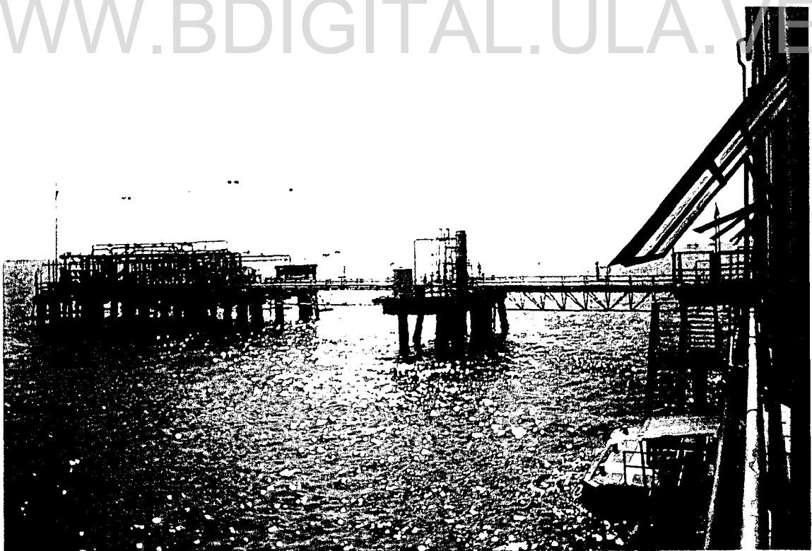
Fotografía B.1. 20.- Plataformas de tambor recolector de condensado del D-1 y la Isla de Distribución.
