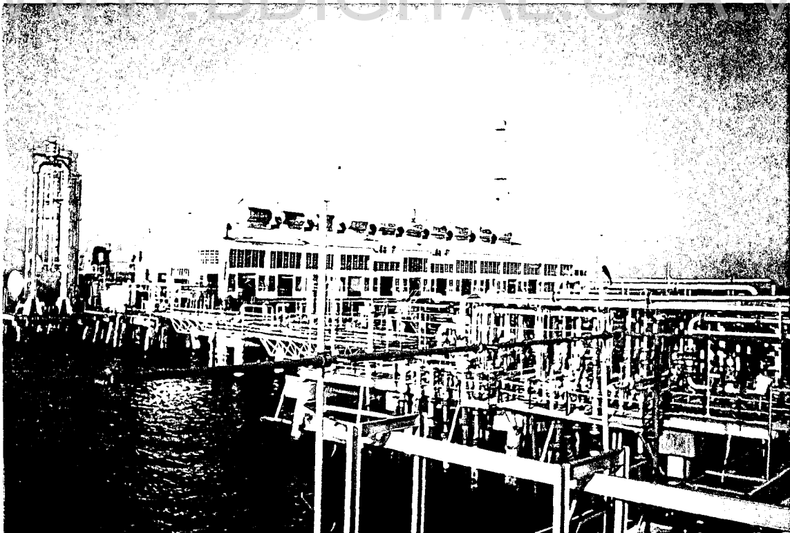
Fotografía B.1. 31.- Planta Compresora
