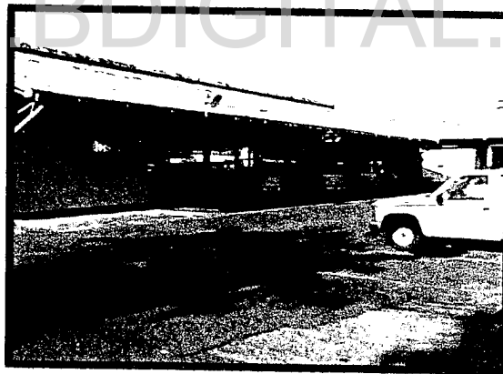
Fotografías 2.2 Sección Línea # 2 (Correctivo / Aire Acondicionado)
