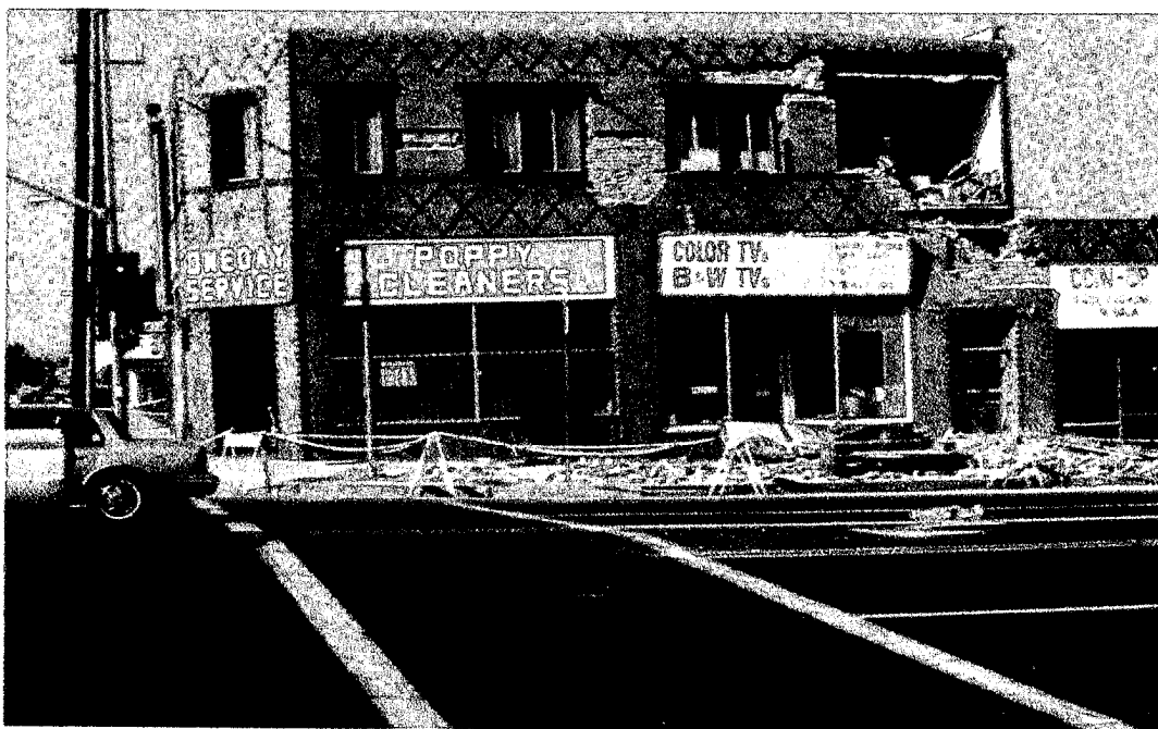
Figura 1.12. Daño en edificación en esquina, 17 de octubre, Northridge, 1994.
