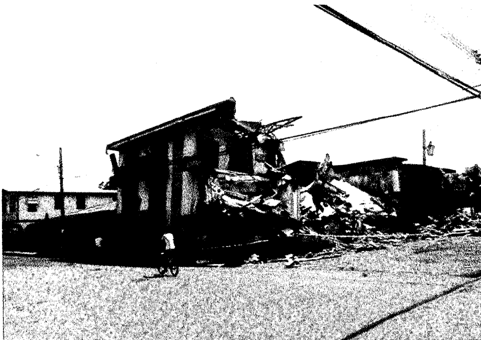
Figura 1.13. Daño en edificación en esquina. 17 de octubre, Northridge, 1994.
