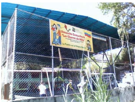
Foto N° 1 Cancha deportiva de la Comunidad Chorros de Milla.
