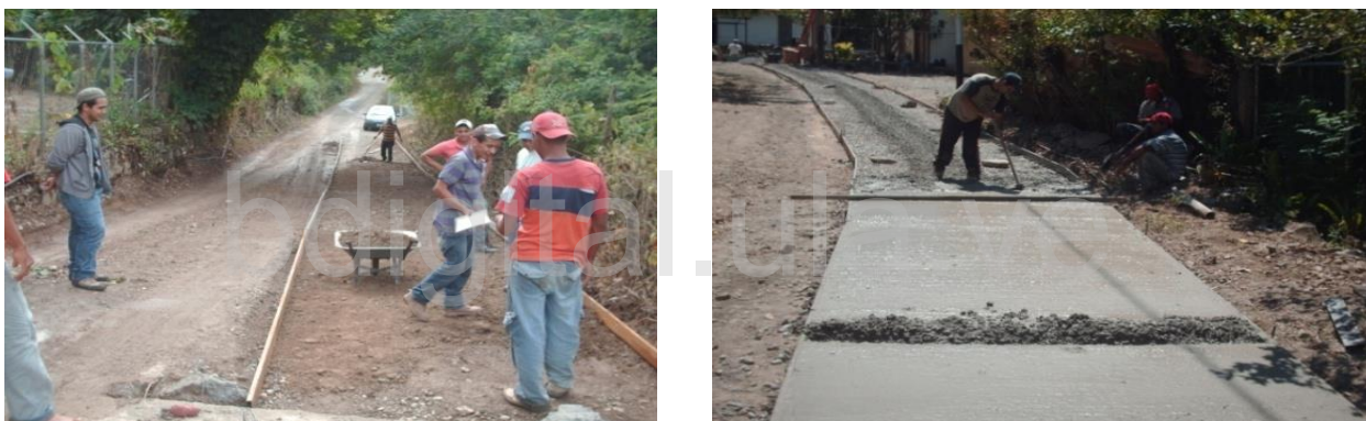
Figura 38. Pavimentación interna de Mocoy Abajo. Fuente : Los Investigadores
