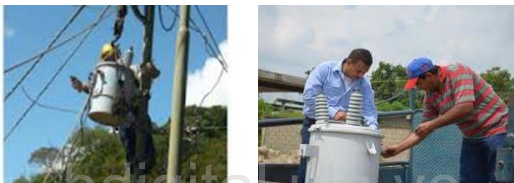
Figura 39. Instalación de transformador en la comunidad. Fuente: Los Investigadores
