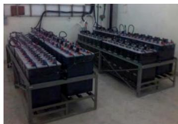
Fig. 12. Modelo del Sistema de Respaldo Eléctrico.
