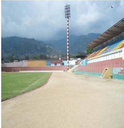
Pista de arena
