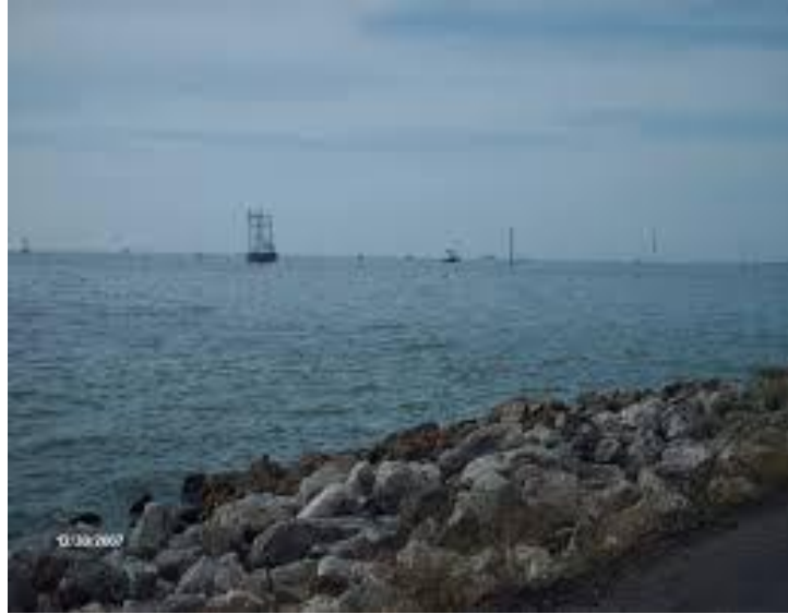
Foto 8. Dique de Lagunillas para la contención del Lago
