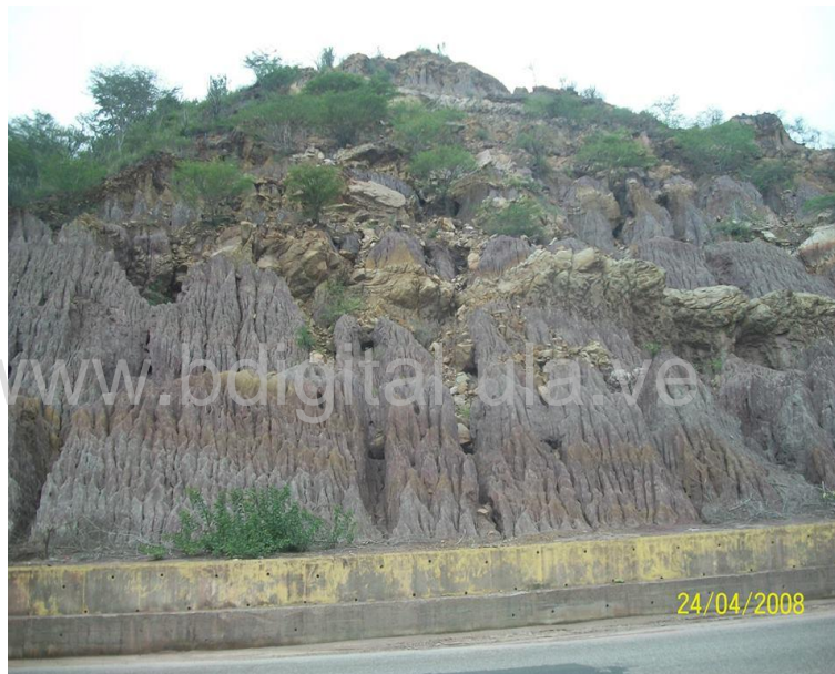
Foto 2. Procesos erosivos por escorrentía en las laderas de las colinas
