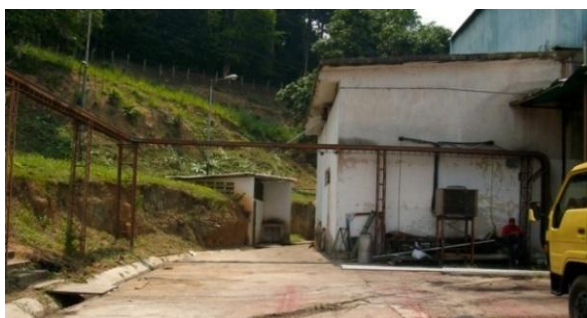
Figura N°4.6. Cableado en bandeja del alimentador del Centro de Distribución Principal.
